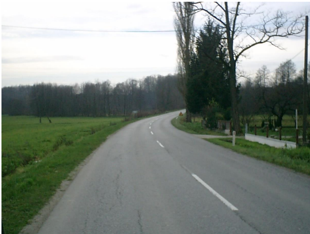
Slika 16. Primjer neprimjerno označenoga desnog opasnog zavoja (autorova fotografija)
