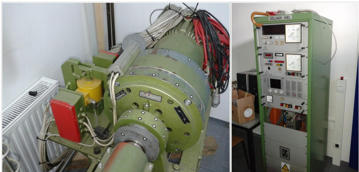
Slika 6. Kočnica Zöllner VA-100 AC DAM 4 RS s pripadajućim upravljačkim ormarom
