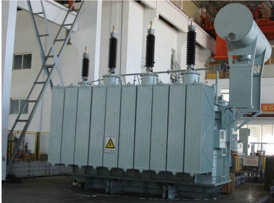
Slika 3. Transformator snage
