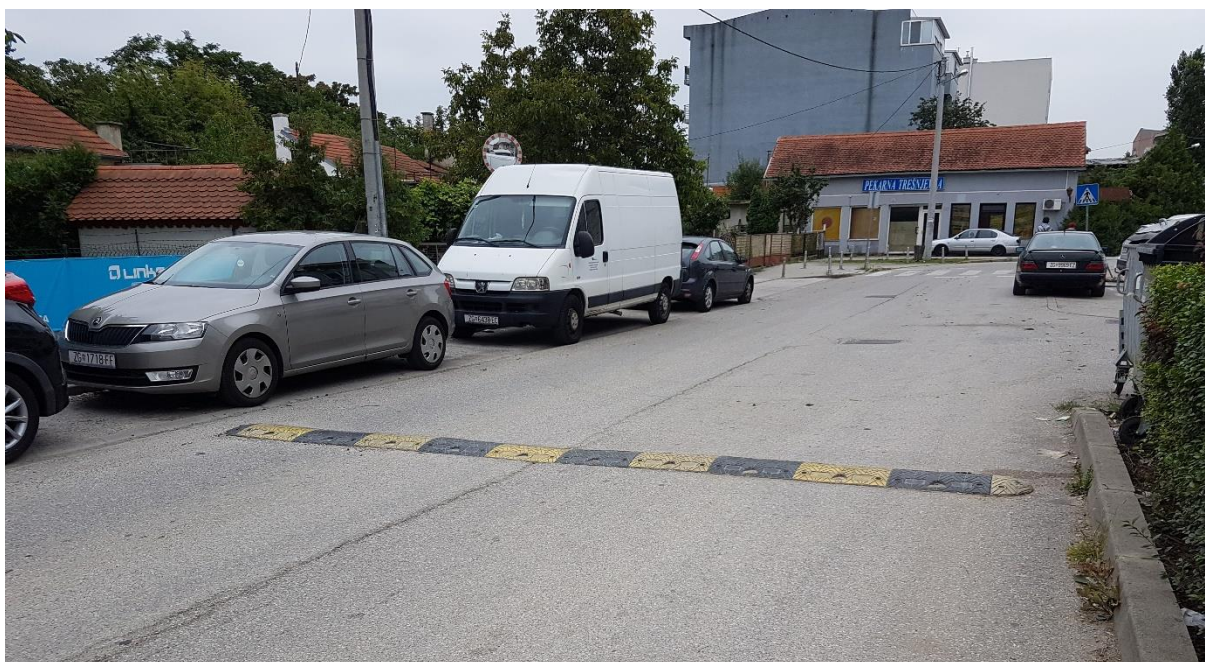
Slika 30. Umjetna izbočina postavljena u Dobojskoj ulici
