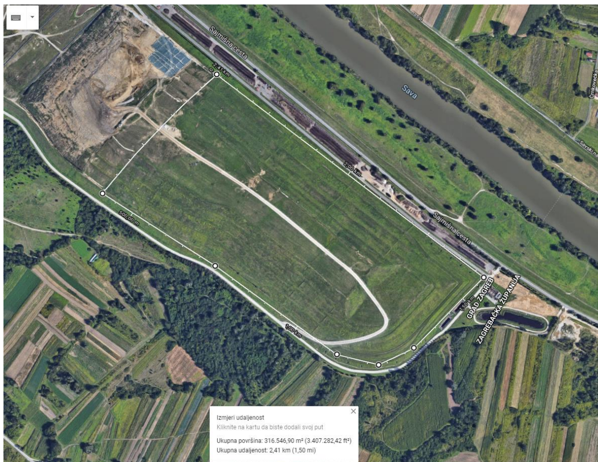
Slika 28. Satelitska snimka saniranog odlagališta otpada površine 316547 m 2 [25]
