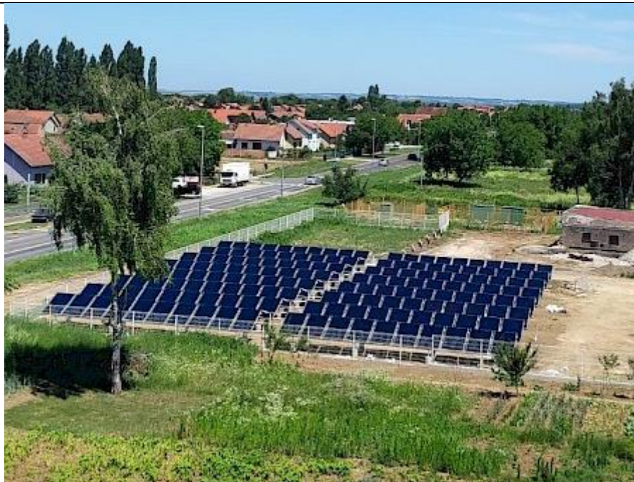
Slika 11. Solarna toplana u Vukovaru [14]
