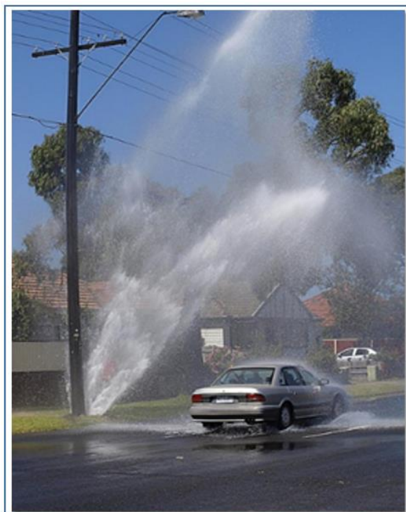
Slika 2.5: Puknuće vodoopskrbnog cjevovoda [izvor: ViO];
