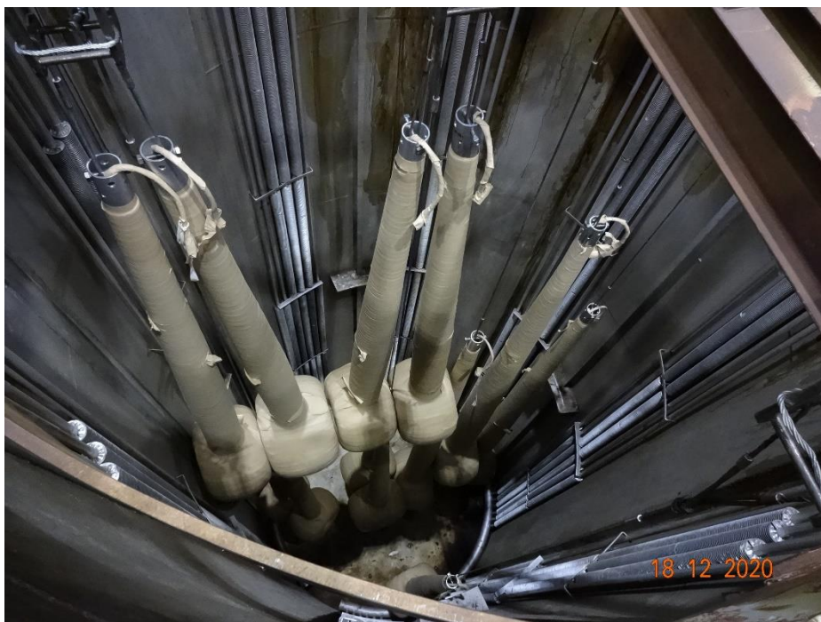
Slika 1.5. Punjenje vakuumske komore transformatorima prije procesa sušenja
