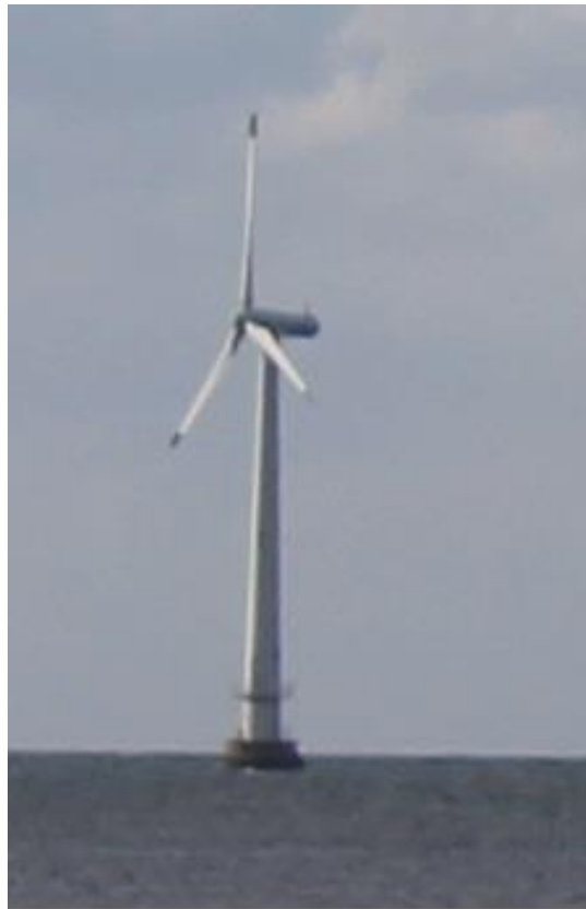
Slika 21. Vjetroturbina Bonus B35/450 (450 kW) [28]
