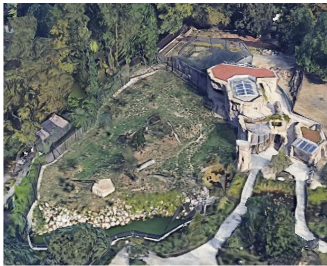
Slika 18 3D model nastambe lavova tijekom izgradnje-google Earth [16]
