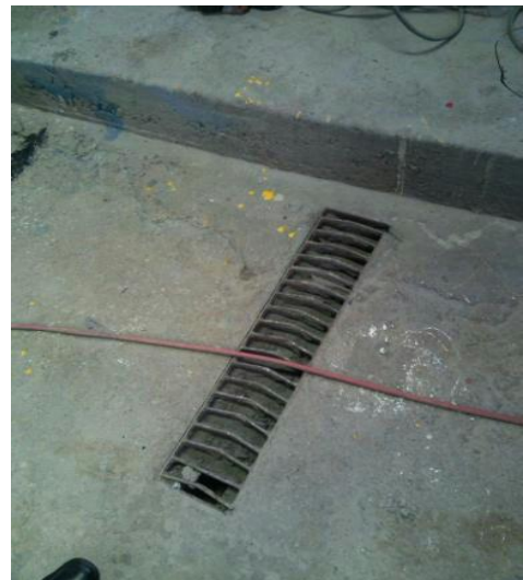
Slika 25 – Odvod onečišćenog zraka
