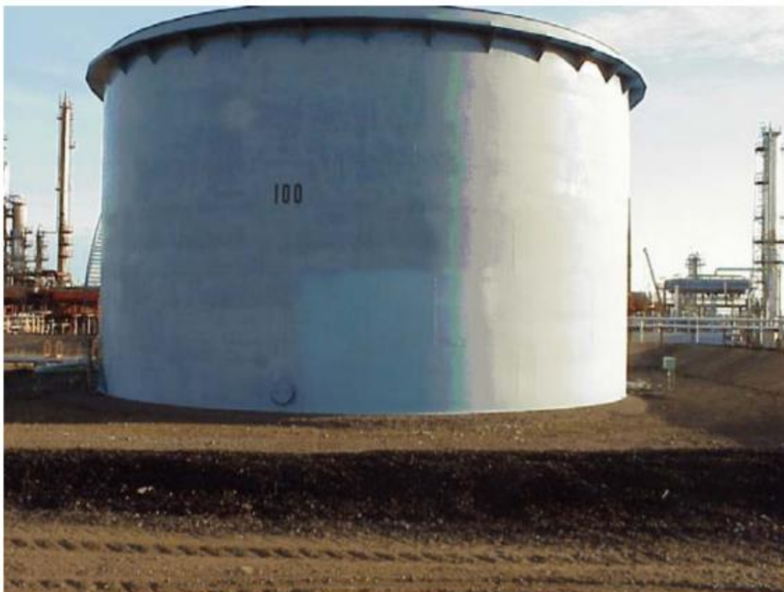
Slika 10. Spremnik ulja zaštićen poliuretanom i vodorazrjedivim akrilom [38]
