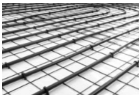
Slika 8. Podno grijanje s rešetkastom konstrukcijom [4]
