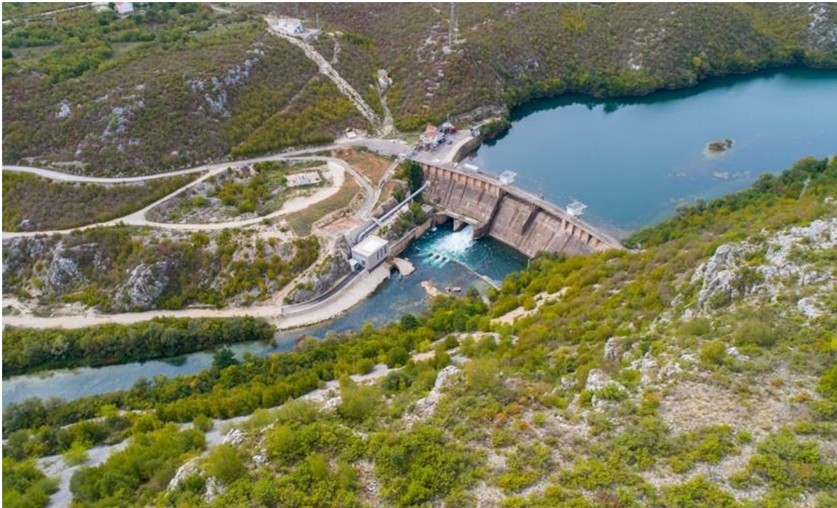
Slika 7. Akumulacija, brana i MHE Prančevići i ulazna građevina HE Zakućac
