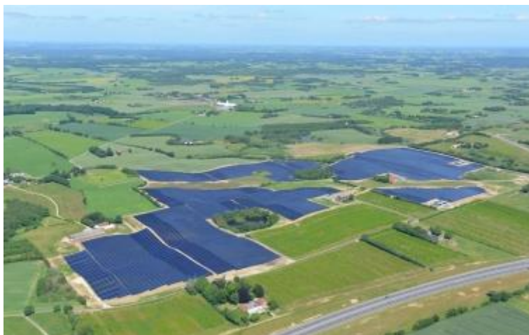
Slika 7. Solarni kolektori u Silkeborgu [9]
