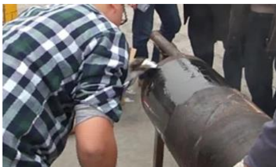
Slika 14. Zaštita cijevi dvokomponentnim epoksidnim premazom [24]
