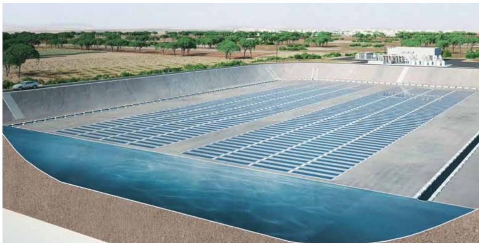
Slika 3.3 Primjer postavljenog FPV sustava na vodi [11]
