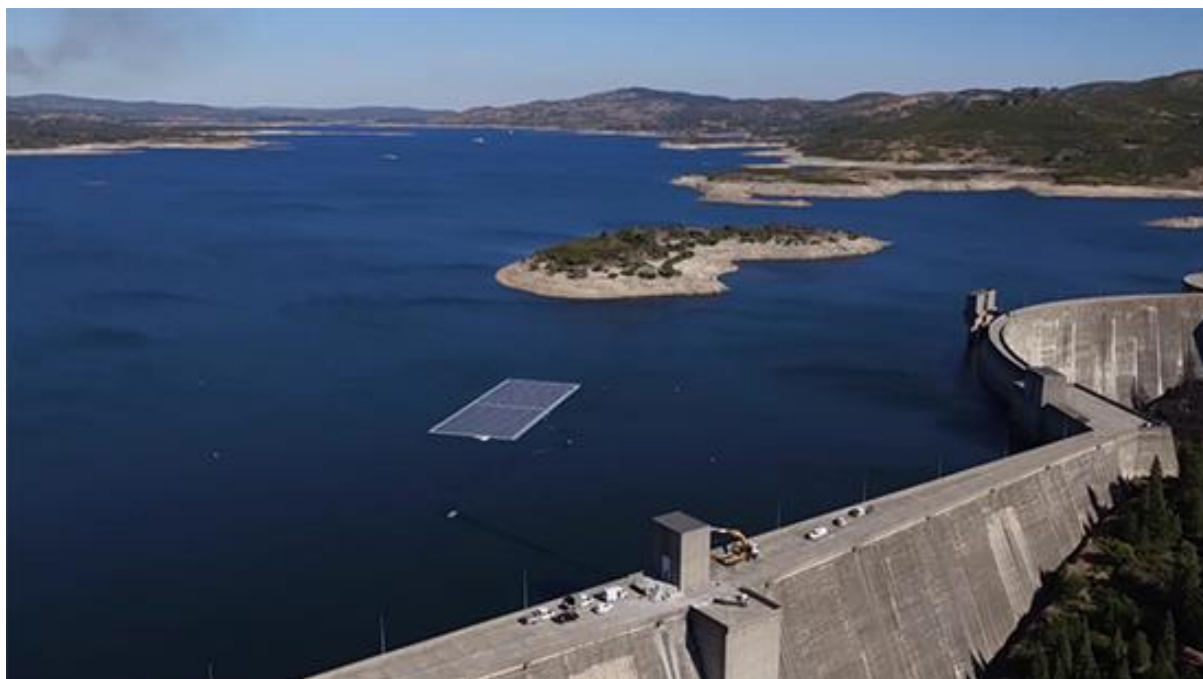
Slika 5.1 Prvo ikad FPV/RHE postrojenje, Montalegru u Portugalu [26]
