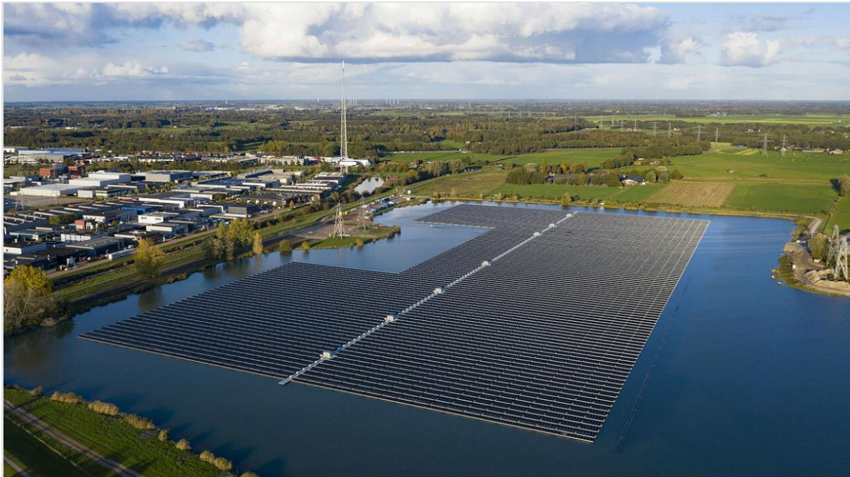
Slika 3.7 Sekdoorn FPV sustav u Nizozemskoj snage 14,5 MW [19]
