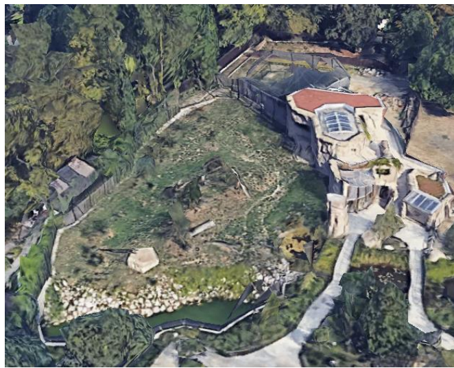
Slika 18 3D model nastambe lavova tijekom izgradnje-google Earth [16]
