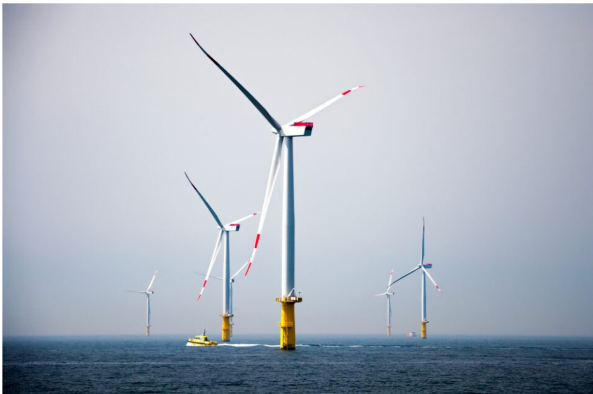
Slika 1. Vjetroelektrane na pučini mora
