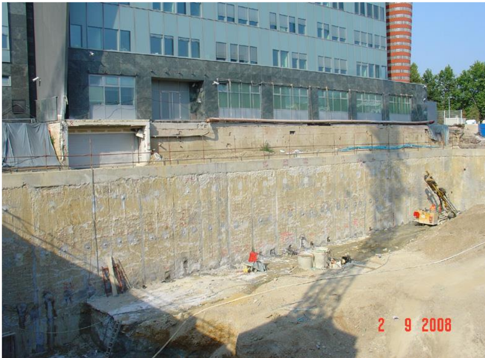
Slika 17. postojeća zgrada RBA uz samu zaštitnu konstrukciju[13]
