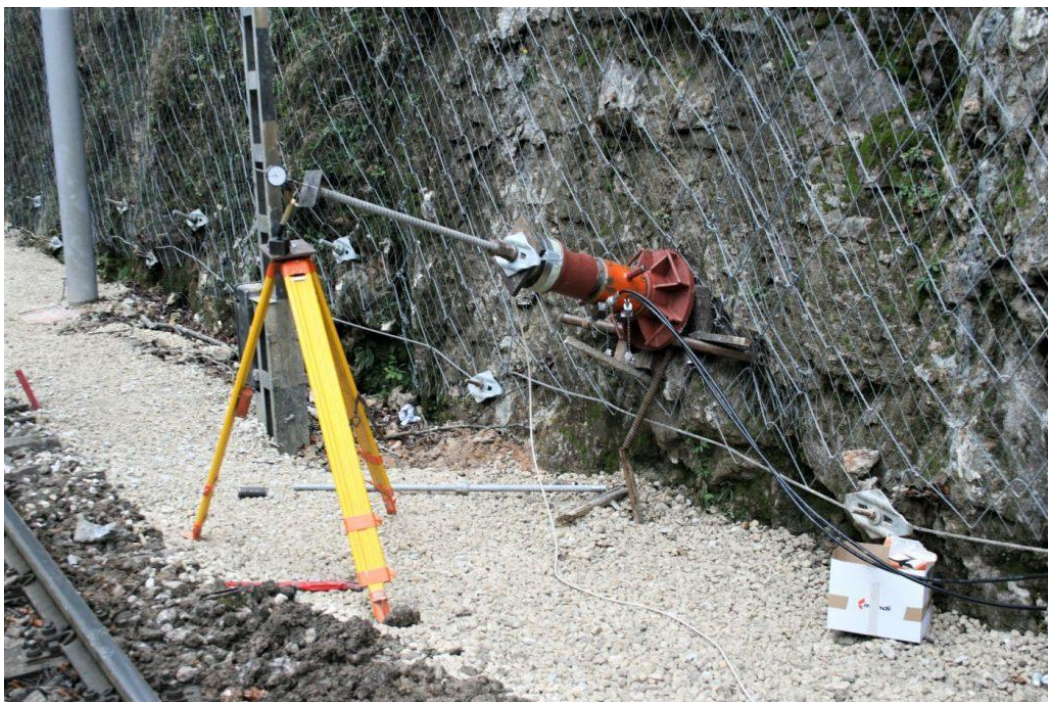
Slika 7. Ispitivanje sidara testom čupanja
