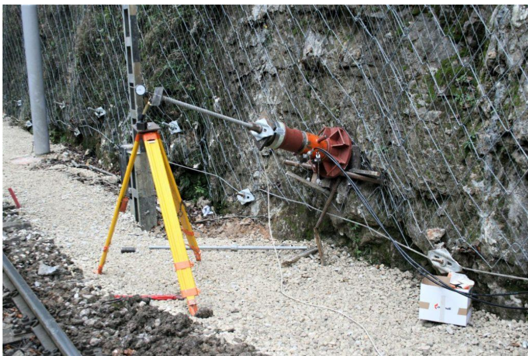
Slika 7. Ispitivanje sidara testom čupanja
