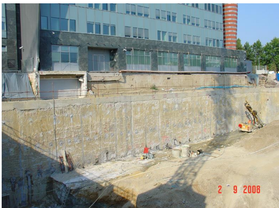
Slika 17. postojeća zgrada RBA uz samu zaštitnu konstrukciju[13]
