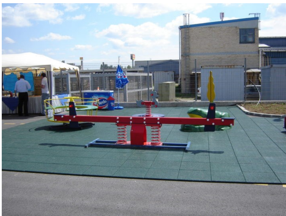
Slika 10. Reciklirane gumene obloge dječjeg igrališta [11]
