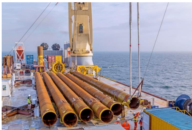
Slika 7 Cijevi za izvođenje pilota
