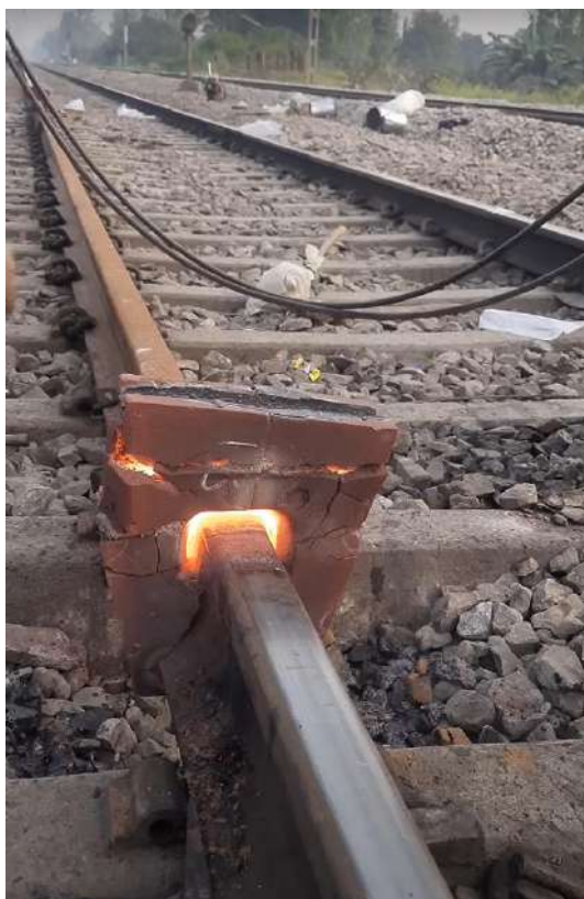
Slika 3.13. Zavareni spoj nakon skidanja kalupa [13]
