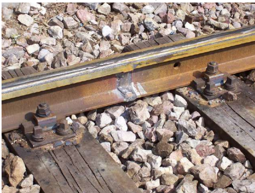
Slika 3.7. Zavareni spoj tračnica [5]
