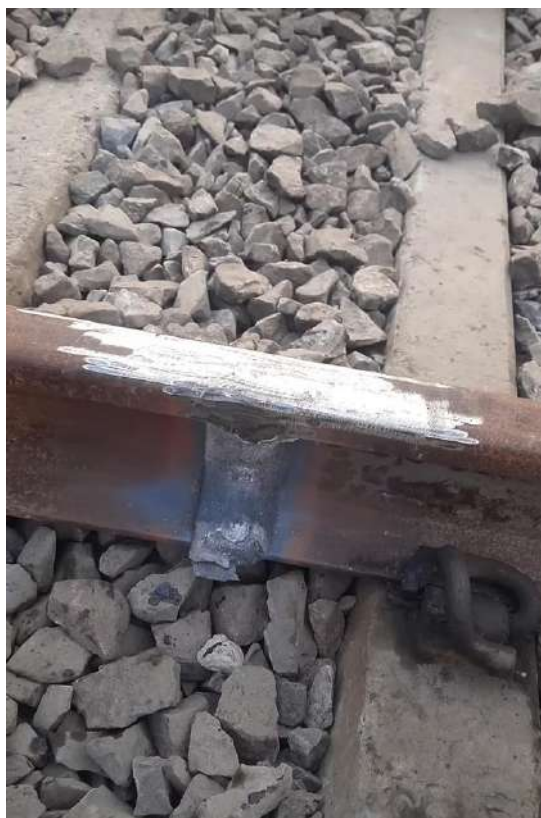
Slika 3.14. Zavareni spoj nakon obrade [13]
