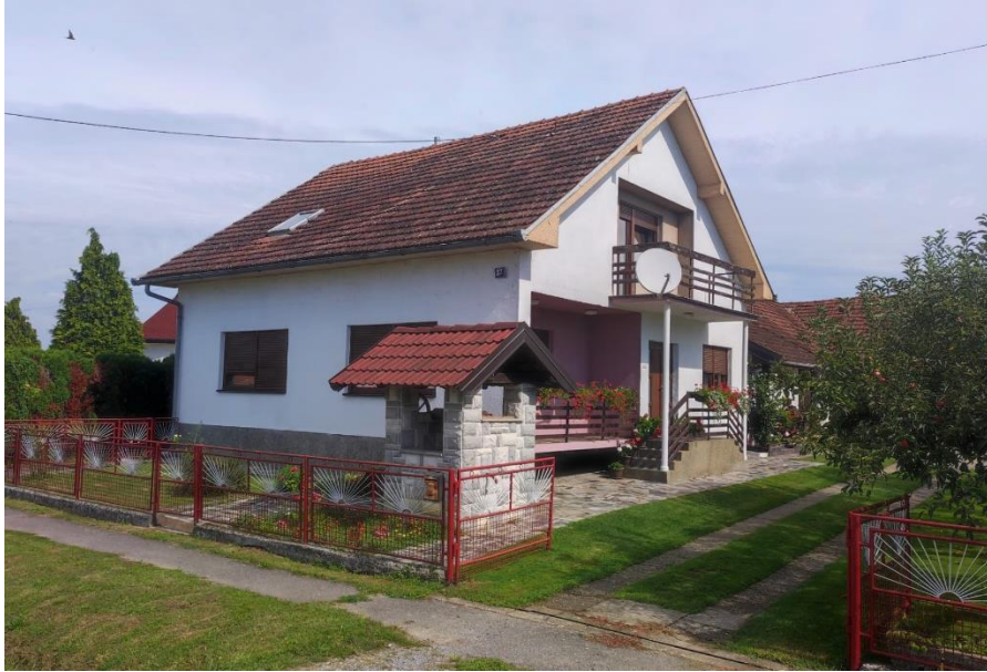
Slika 3.1. Pogled s južne strane zgrade
