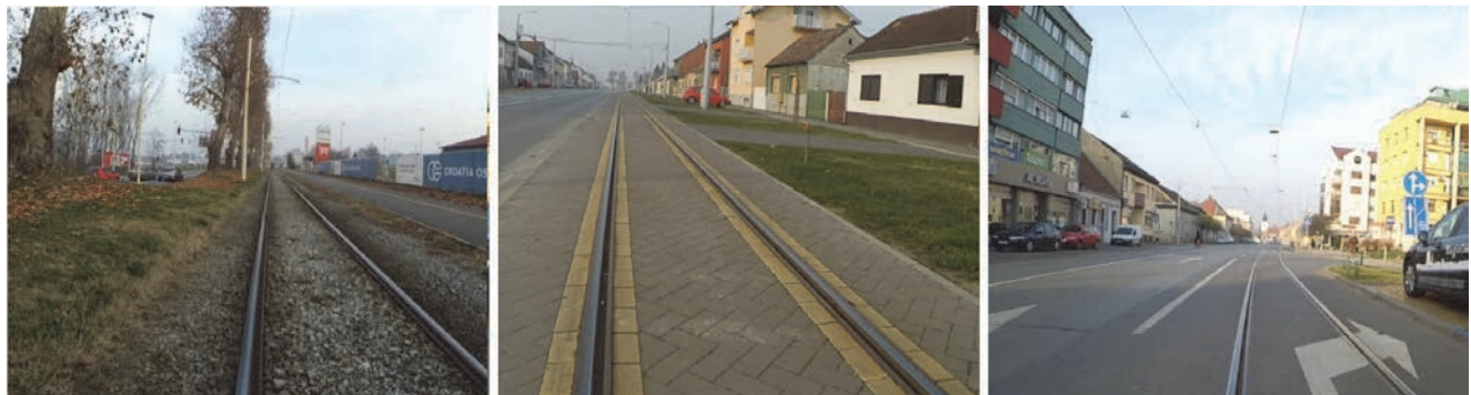
Slika 2. Različite vrste tramvajskih kolosijeka u Osijeku
