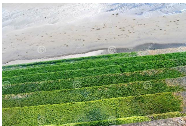
Slika 17 Alge na betonskim stepenicama
