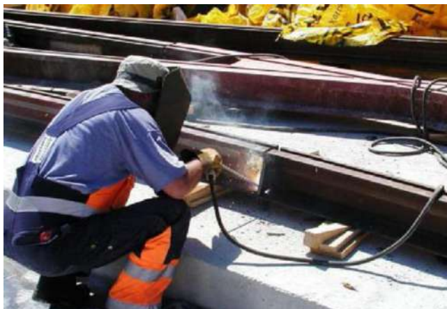
Slika 3.15. Zavarivanje žljebaste tračnice REL postupkom uz upotrebu čelične ploče [15]
