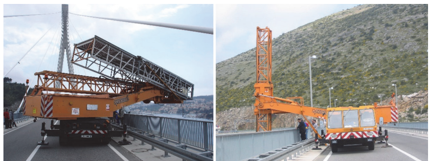
Slika 11. Pregled mosta Franje Tuđmana u Dubrovniku, 2005. godina [28]
