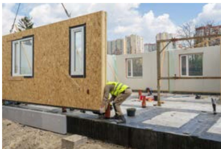
Slika 35.: Pozicioniranje montažnog elementa (Izvor: [42])
