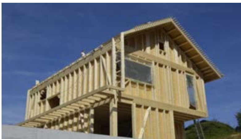
Slika 17.: Skeletna montažna gradnja s OSB pločama (Izvor: [26])
