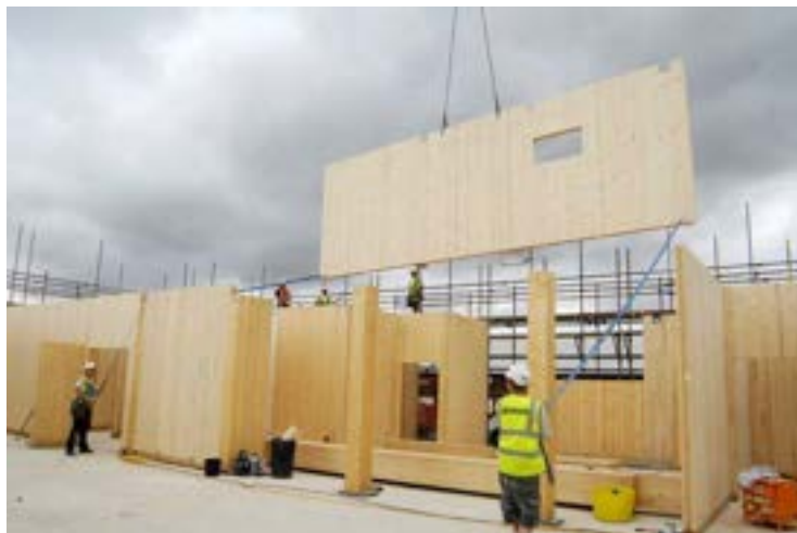
Slika 34.: Gradilišni transport elementa toranjskom dzalicom (Izvor: [42])
