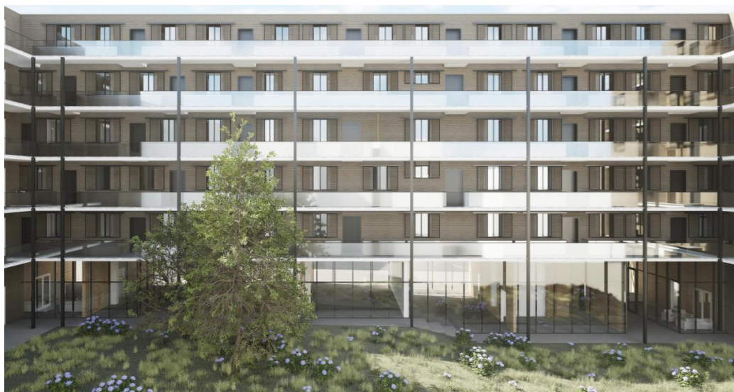
Slika 3.2. Pogled na konstrukciju – jug
