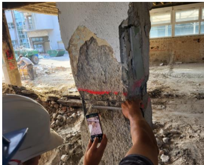
Slika 83.: Naknadna provjera ugrađene armature [26]
