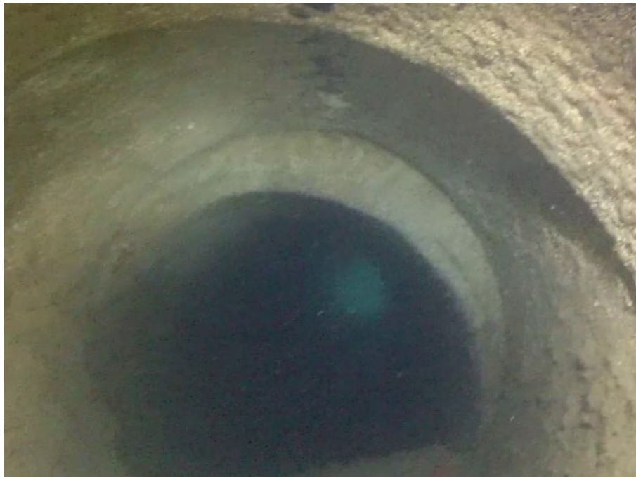
Slika 81 Fotografija slijevanja cijevnih sekcija propusta u ACI marini Opatija što može utjecati na protočnost kroz propust uslijed plime i oseke
