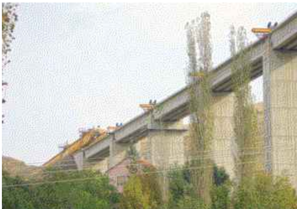
Figure 8 Viaduct in construction on the section n.12 Beljakovci–Kriva Palanka
