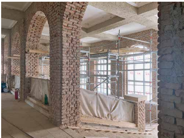
Zgrada staroga dekanata - obnova stare vijećnice.
