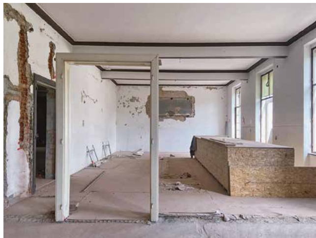
Zgrada staroga dekanata - obnova glavnog stubišta.
