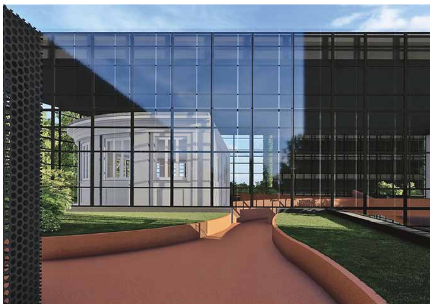
Slika 3. Predavaonica nekadašnje Dermatološke klinike zadržana je i smještena kao povijesni simbol u unutrašnjost zgrade, gdje će i dalje služiti kao dio konferencijske infrastrukture. Zelena površina kojom se na ovoj slici pristupa dvorani s njezine južne strane, nalazi se na krovu prizemlja. Dermatološka dvorana vidljiva je i na prethodnoj slici 2 kroz staklenu oblogu središnjeg krila.
