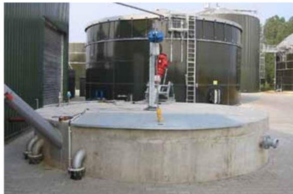
Slika 11. Prihvatni spremnik ( eng. preliminary pit ) (Bontempo i sur., 2016).
