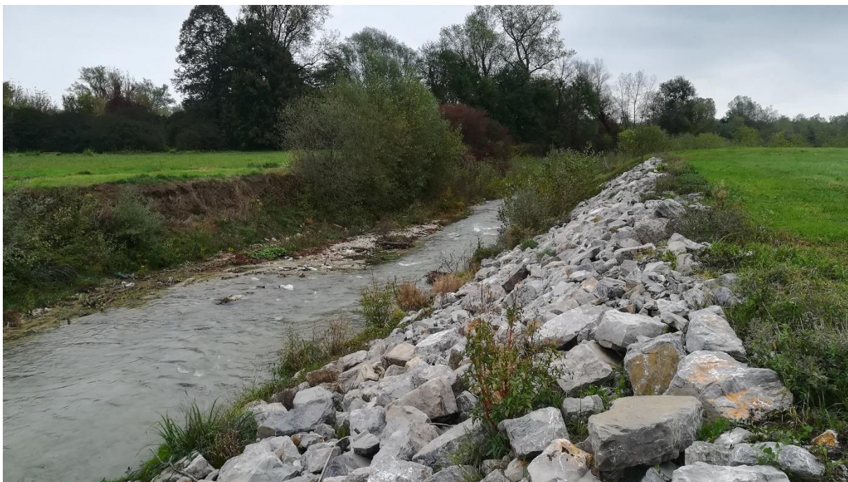
Sl. 28. Kameni nabačaj na desnoj obali Bregane nedaleko ušća u Savu; na lijevoj obali su vidljiva erozijska oštećenja obale (snimila V. Curman, 09.10.2021.)
