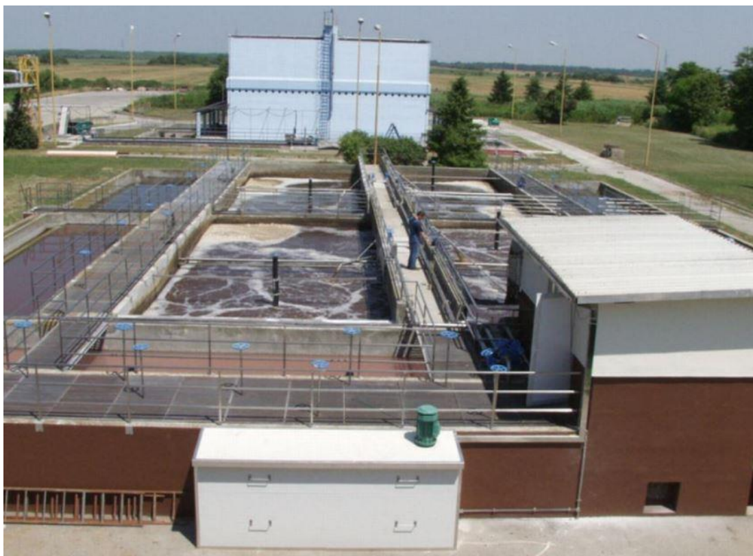
Sl.22. Postrojenje pročistača za obradu otpadnih voda Izvor: Fišter, 2012.
