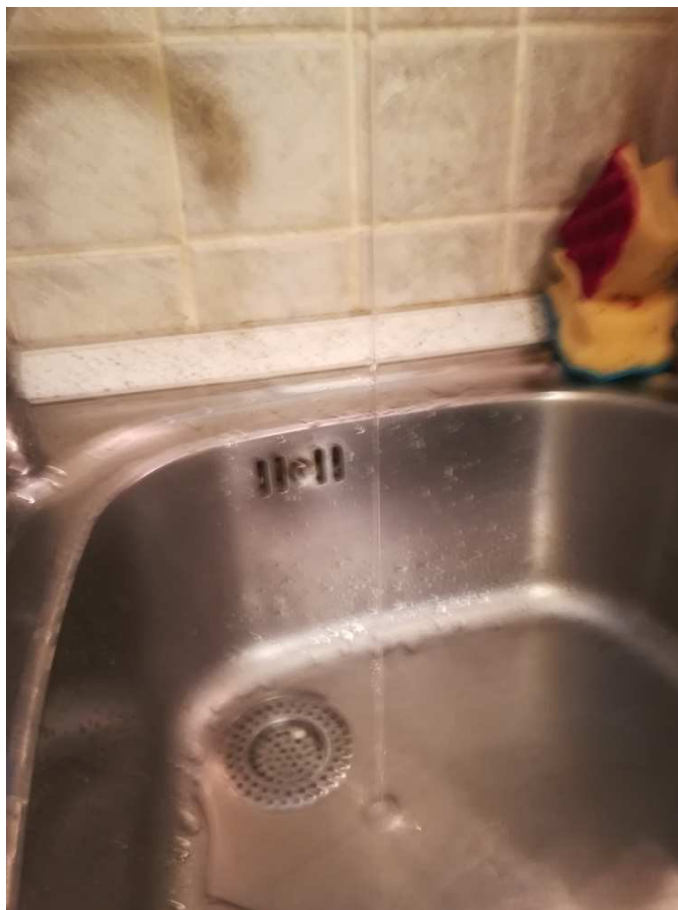
Slika 5.2: Ravan mlaz vode
