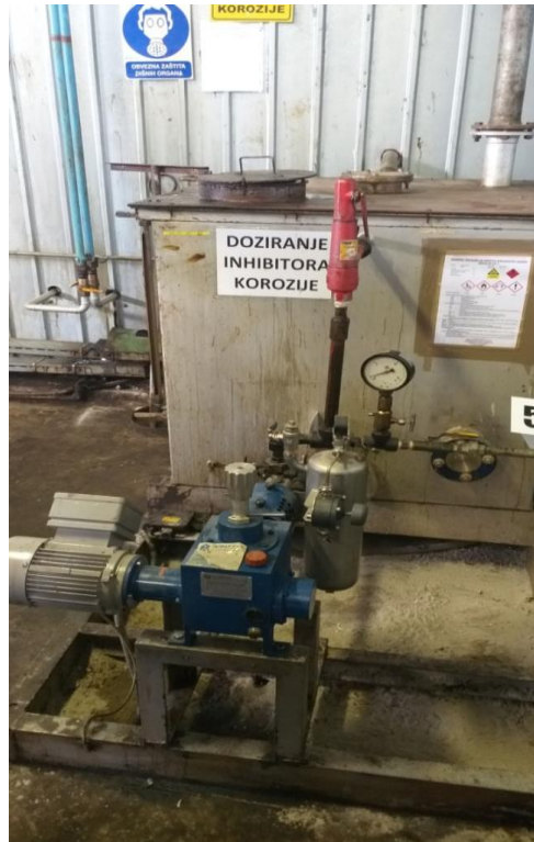
Slika 7-2 Uređaj za doziranje inhibitora na polju Đeletovci
