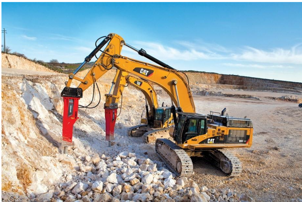
Slika 1-1. Hidraulični čekići u kamenolomu (Iskop hidrauličnim čekićem, 2013.)
