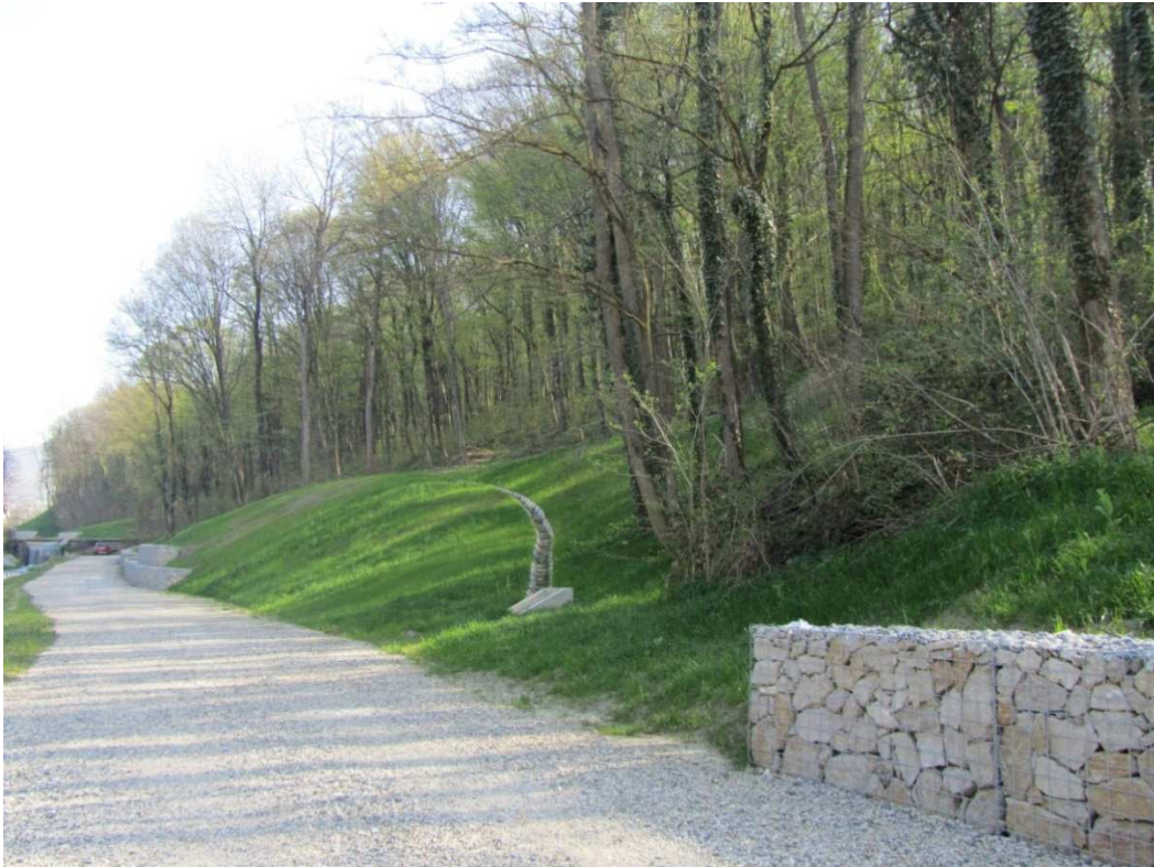
Slika 80 Područje uz Veliki potok na kojemu su u razdoblju nakon 2008. godine izgrađeni gabionski zidovi, drenaže i uređen je donji dio padine uz potok (snimljeno 2013. godine)
