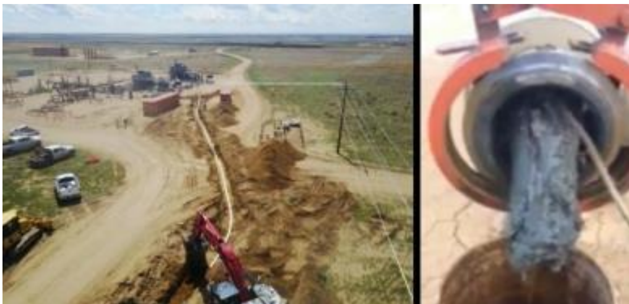
Slika 3-11. Postavljanje ojačanih PA-PERT cijevi promjera 152,4 mm (6") (lijevo) i čepovi parafina u čeličnoj cijevi (desno) (Chang i ostali, 2018)
