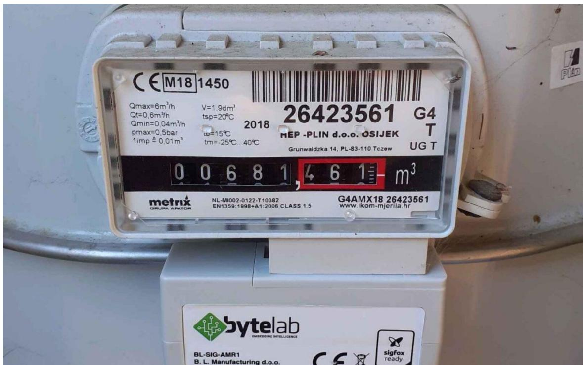
**Slika 6-3.** Membransko plinsko brojilo s Byte Lab senzorskim modulom za očitanje ([www.netokracija.com](http://www.netokracija.com), 2020)
