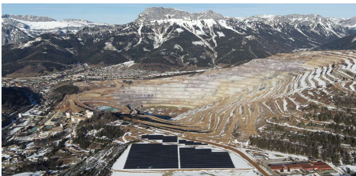
Slika 4-12. Sunčana elektrana Erzberg, Austrija (energy3000, 2024)
