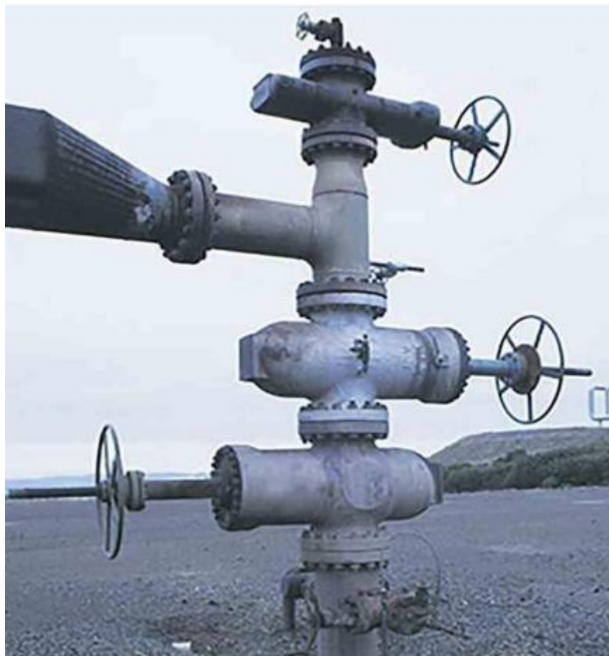
Slika 5-2. Bušotinska glava geotermalne bušotine (Schlumberger, 2020)
