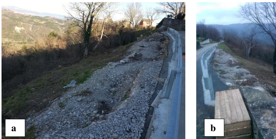
Slika 3.1 (a,b) Čeona pukotina klizišta Sovinjak a rubu ceste s denivelacijom gornjeg dijela pokrenute mase u iznosu od 0,95 m (snimio Ž. Arbanas 14.2.2015.).
