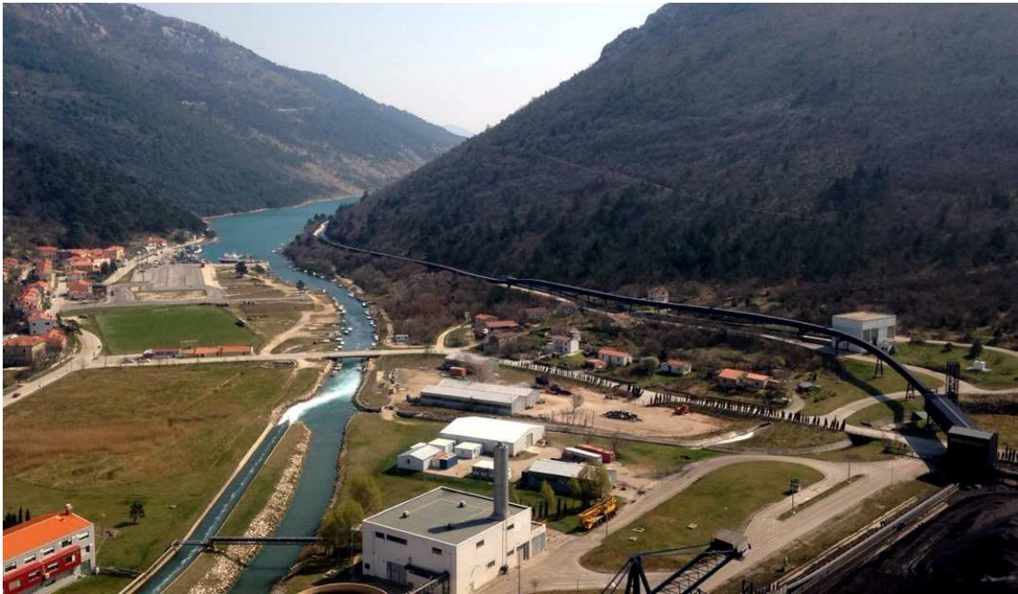
Slika 4-3. Pogled na Plominski zaljev sa TE Plomin
