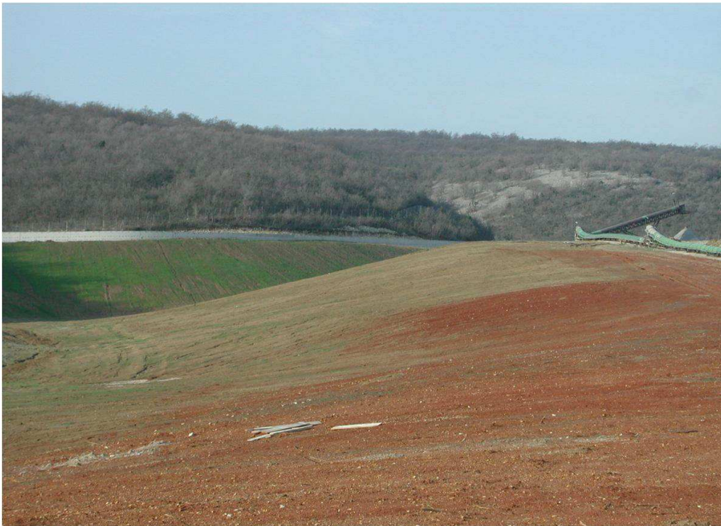
Slika 4-12. Sanirano odlagalište pepela, šljake i gipsa (Vukelić, 2013.)
