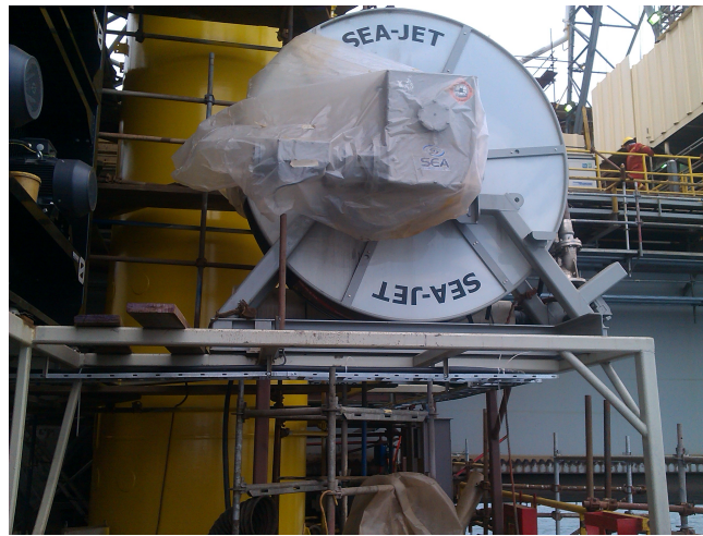
Slika 5-13. Novi bubanj s fleksibilnim crijevom za dobavu morske vode (Crosco, 2015c)
