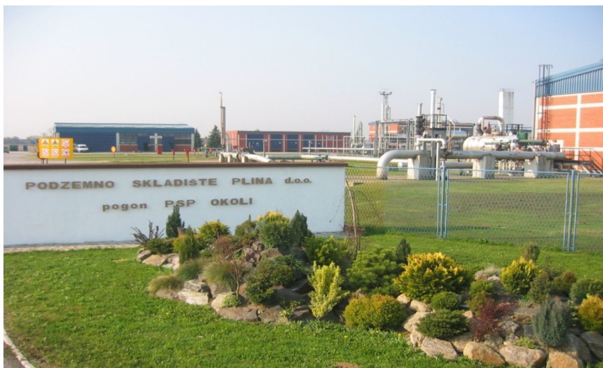
Slika 2.6: Podzemno skladište plina Okoli, Hrvatska ( https://psp.hr )
