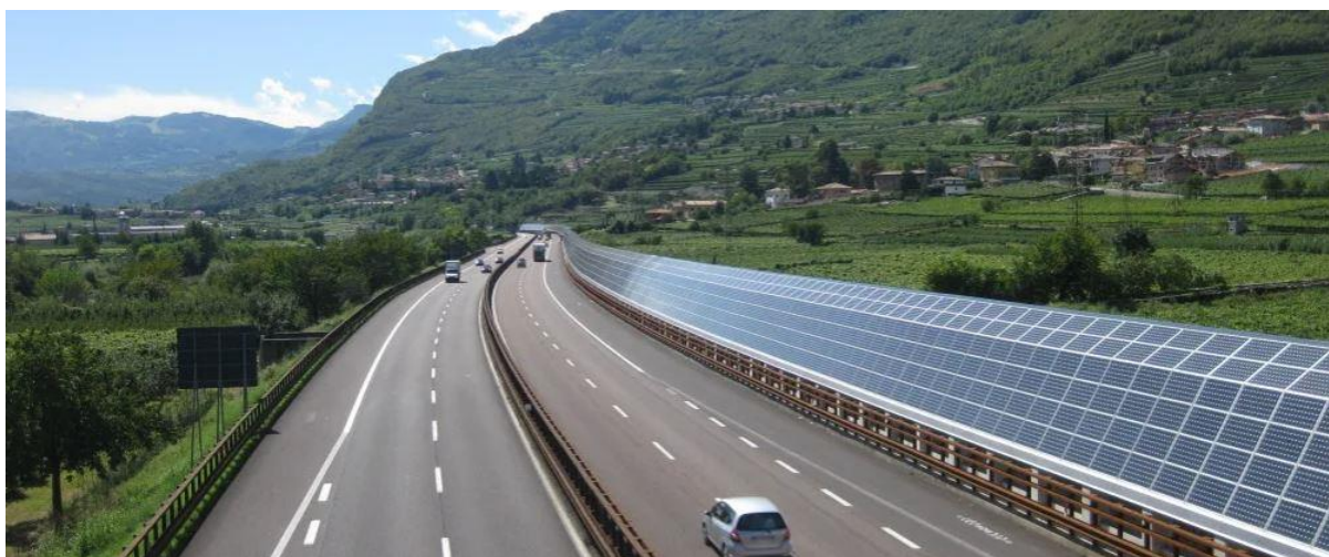
Slika 28. Primjer zvučne barijere s fotonaponskim panelima [50]
